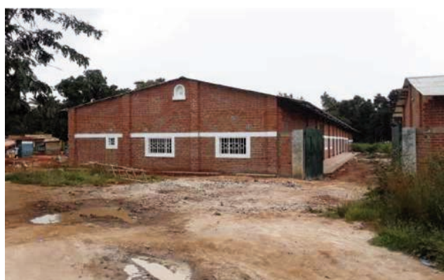
Imagen de la nueva edificación del internado en Kanzenze
