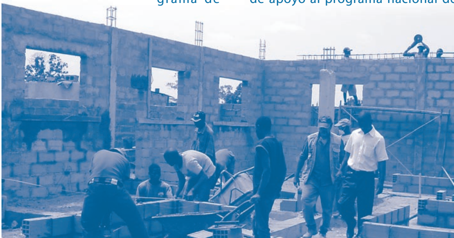
Construcció de noves infraestructures sanitàries al municipi de Viana (Angola)
