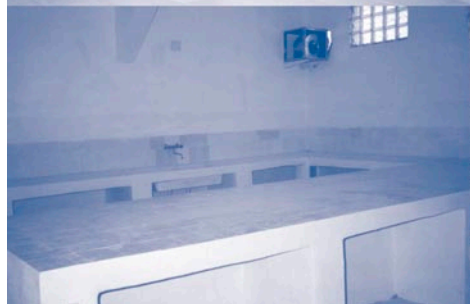
Adecuación de la zona de producción
