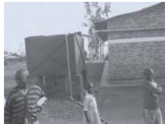
Recogida de aguas pluviales en el C.S. de Mugina
