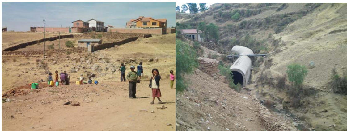
Ilustración 18 y 19. En la barriada de Belén los vecinos acceden al agua potable a través de una fuente pública con bidones. En la barriada de Israel en el verano de 2008 se estaban realizando las obras de alcantarillado canalizando las aguas de un arroyo.
