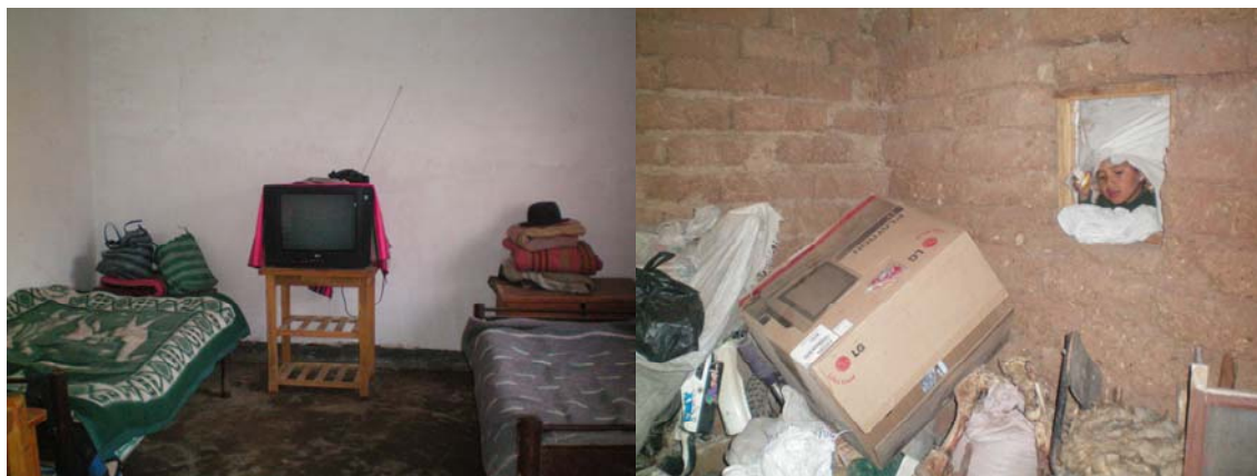
Ilustraciones 16 y 17. Obsérvese la diferencia entre una habitación revocada y acondicionada (barriada de Belén), además de pulcra y ordenada, y otra que aún no ha sido remodelada (barriada de Israel).
