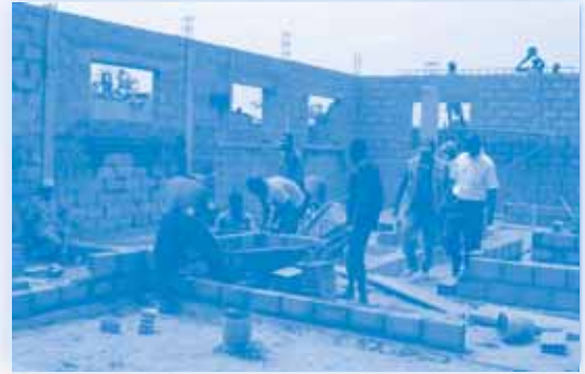
Construcció d'infraestructures a Viana
