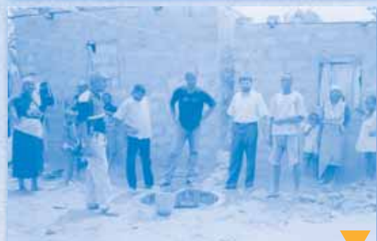
Construcció de latrines a Viana
